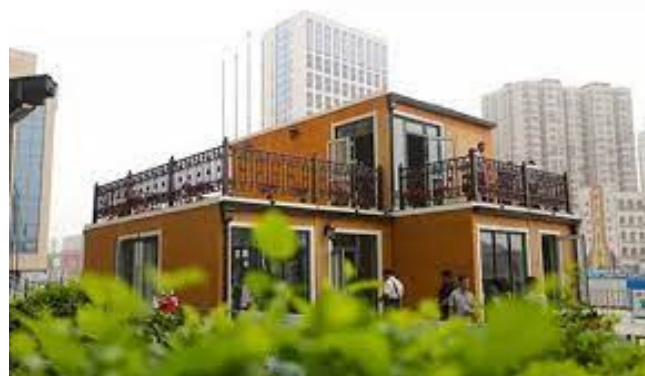
Рисунок 2. Двухэтажная вилла в Китае, построенная с помощью 3D принтера
