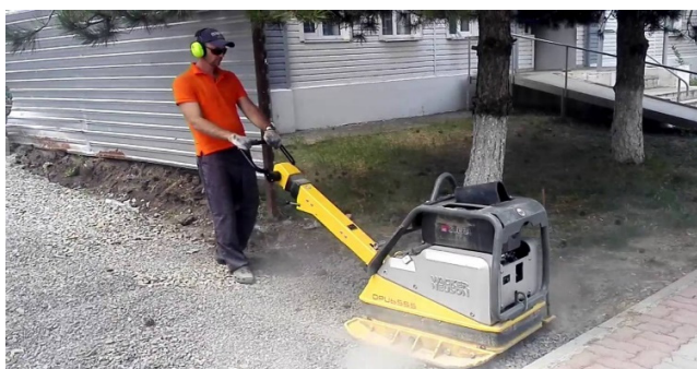
Рисунок 4 – Трамбование щебня
