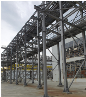
Изображение №1: Общий вид металлоконструкций комплекса производства элементарной серы
