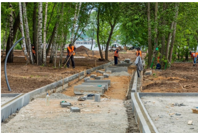
Рисунок 2- Укладка тротуарной плитки
