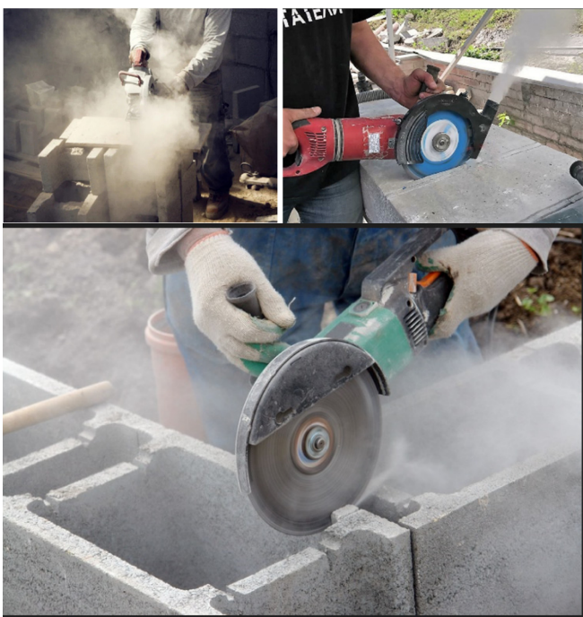
Рисунок 3 – Работа угловой шлифовальной машиной
