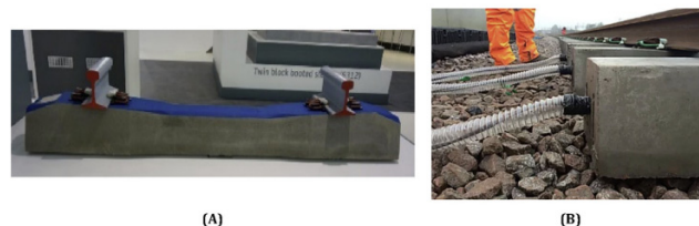
Рисунок 8 (А) Шпала Consolis [81], (В) шпала со встроенными датчиками FBG
