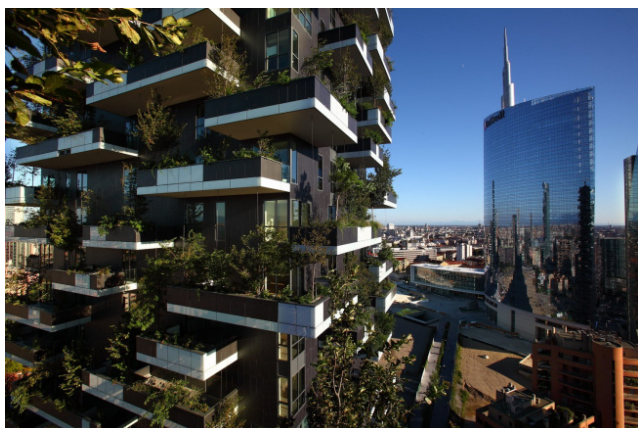
Рис. 4. Жилой комплекс Bosco Verticale (г. Милан) Источник URL: https://archi.ru/projects/world/8818/zhiloi-kompleks-bosco-verticale .
