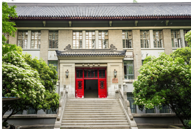
Рис 4 Здание Юго-Восточного корпуса Нанкинского университета, 1953 год.
