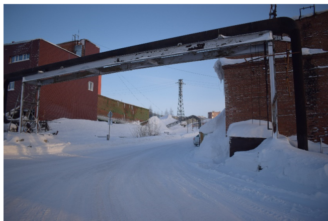
Рис. 3. Пересекаемая эстакада теплосети
