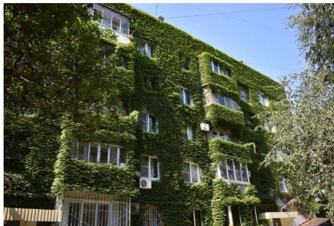
Рис. 9. Вертикальное озеленение фасада жилого дома (г. Ростов-на-Дону) Источник URL: https://www.rostov.kp.ru/daily/28321/4465552/ .
