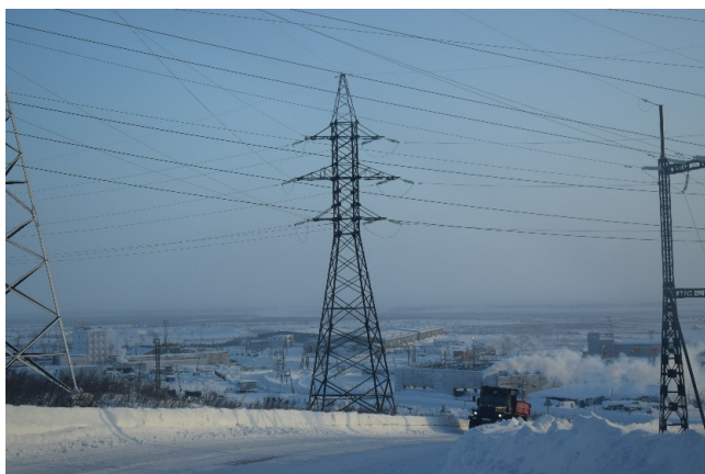
Рис. 1. Пересекаемое препятствие – высоковольтная линия электропередач
