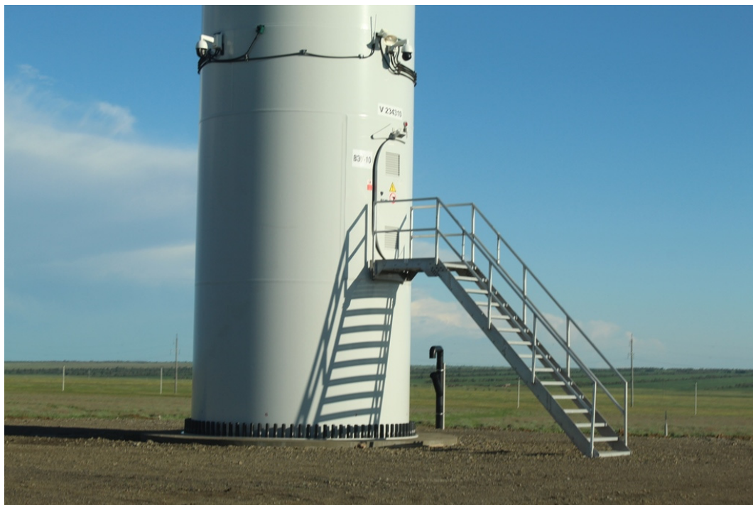
Фото 2. Система птицевозащитной сигнализации, Троицкое. Фото Сангаджиева М.М.
