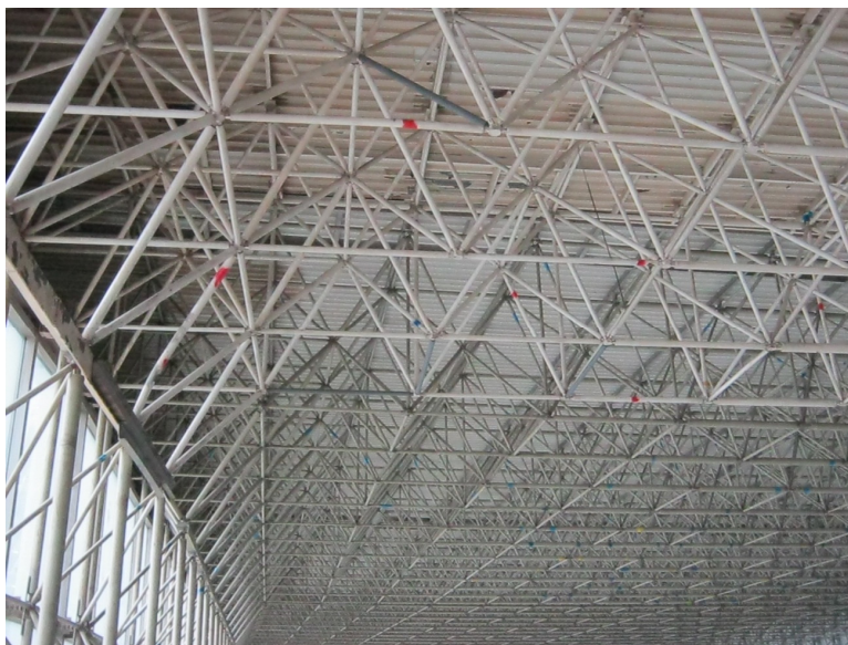
Рисунок 3. Общий вид на ригельную часть конструкции покрытия машинного зала. Стержневые элементы с нанесенной цветовой маркировкой
