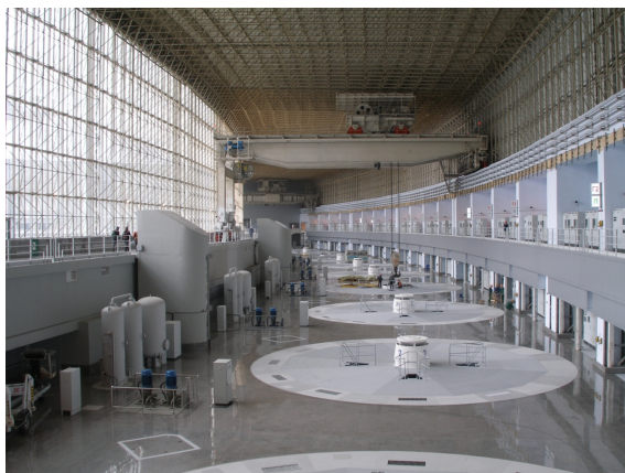
Рисунок 1. Общий вид шатра машинного зала и полукозлового крана
