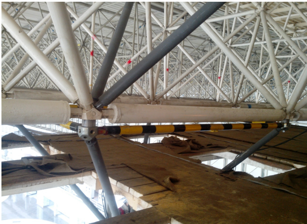
Рисунок 6. Общий вид сопряжения элементов разгрузочной рамки и элементов нижнего пояса ПСПК
